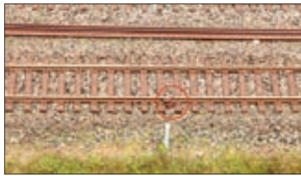
Die neue Gleistreunung haben wir vorverlegt und die alte sauber verlötet und wieder eingefärbt.
